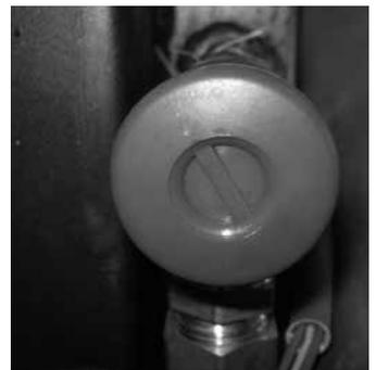
**Valve de sécurité:** cette vanne agit pour empêcher une surpression du système hydraulique. Si la pression de l'hydropoêle ou le système est supérieure à 2,5 bar, il draine l'eau du circuit.
