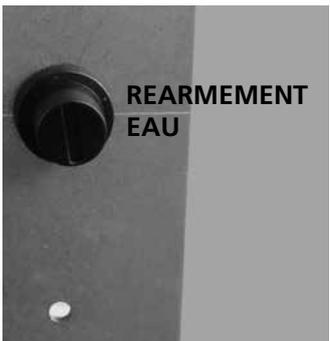
**Thermostat de sécurité à réarmement manuel pour la température de l'eau:** si la température de l'eau dépasse le niveau de sécurité programmée à 100°C arrête immédiatement le fonctionnement de l'appareil et l'écran affiche "**ALARQ SICQFAIL**". Pour redémarrer, vous devez réinitialiser le thermostat manuellement.
