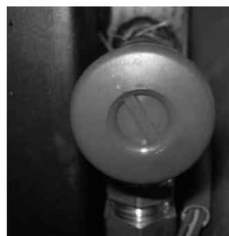
**Valve de sécurité:** cette vanne agit pour empêcher une surpression du système hydraulique. Si la pression de la chaudière ou le système est supérieure à 3 bar, il décharge l'eau du circuit.
