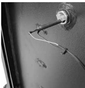
**Sonde de température de l'eau:** ce thermocouple détecte la température de l'eau et ajuste le fonctionnement de la chaudière.
