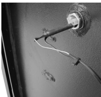
**Sonda di temperatura acqua:** se la temperatura dell'acqua si avvicina alla temperatura di blocco (100 °C) la sonda impone di interrompere l'alimentazione del pellet.
