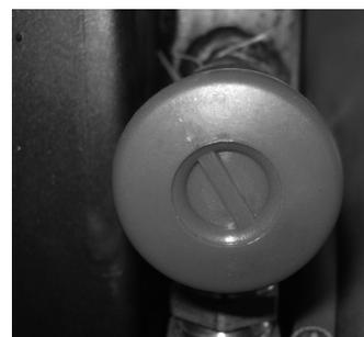
**Valvola di sicurezza:** questa valvola interviene per prevenire una sovrappressione dell'impianto idraulico. Se la pressione della caldaia o dell'impianto supera i 2,5 bar essa scarica l'acqua dal circuito.
