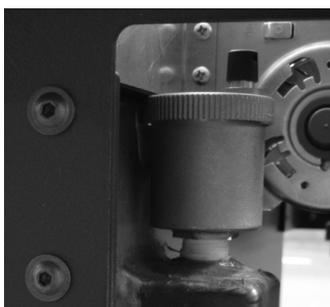
**Valvola di sfiato automatica:** questa valvola elimina l'aria all'interno della caldaia e dell'impianto di riscaldamento.
