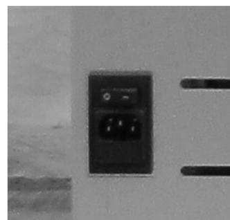
**Sicurezza elettrica:** la caldaia è protetta contro gli sbalzi violenti di corrente (es. fulmini) da un fusibile generale a 4 A che si trova nel pannello comandi posto sul retro della caldaia vicino al cavo di alimentazione. Altri fusibili per la protezione delle schede elettroniche sono situati su quest'ultime.
